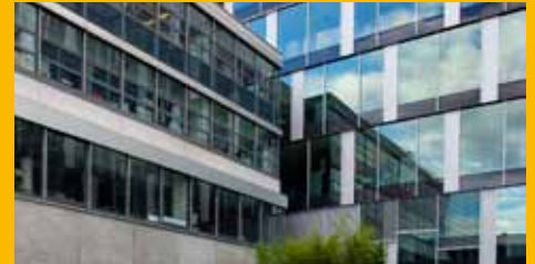
KLEBEN UND DICHTEN IM FASSADENBEREICH
